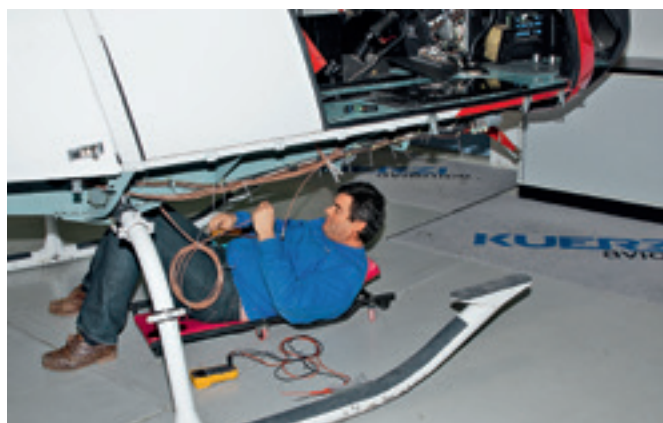
Ici, les ingénieurs travaillent également sur les aéronefs: René Zingre lors de l'installation d'un nouveau câble d'antenne.
